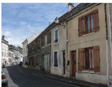
La construction forme un parallélogramme rectangle sur deux niveaux, surmonté d'un toit à deux pans entre 35° et 45°. Il est parfois encadré de souches de cheminée maçonnées.
