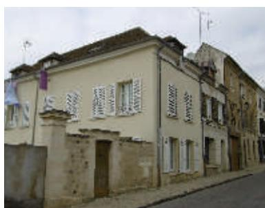
La tuile plate en terre cuite, parfois l'ardoise, le moellon calcaire enduit constituent les matériaux de construction des grandes maisons. Les modénatures tels que corniches, bandeaux, moulures sont la plupart du temps en plâtre. Les encadrements de fenêtre sont en moellon enduit, parfois en pierre. Un soubassement en pierre dure protège la partie basse du mur.
