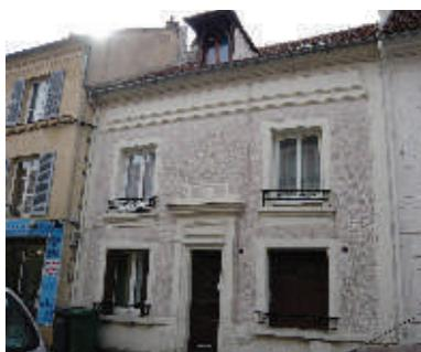
La tuile plate en terre cuite, le moellon calcaire enduit, constituent les matériaux de construction des maisons de village. Les chaînages sont rarement apparents car souvent recouverts d'un enduit. Les rares modénatures tels que corniches, bandeaux sont en plâtre. Les encadrements de fenêtres sont en moellon enduit, parfois en pierre.
