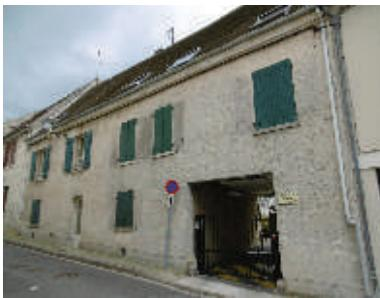
La construction forme un parallélepède rectangle sur deux niveaux, surmonté d'un toit à deux pans entre 35° et 45°. Il est parfois ponctué de souches de cheminée en maçonnerie.
