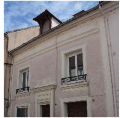
Quand les maçonneries sont en pierre de taille, les appareillages et les compositions de façade sont soignées. Non enduites, elles laissent visible la finesse des joints et l'appareillage.
