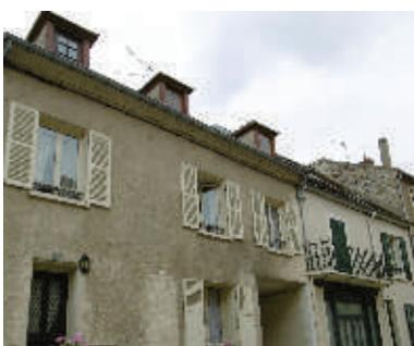
La tuile plate en terre cuite, le moellon calcaire enduit et la pierre de taille constituent les matériaux de construction des maisons de bourg. Les modénatures, tels que bandeaux en plâtre sont devenues rares. Les encadrements de fenêtre sont en moellon enduit. Le soubassement en pierre dure enduit protège la partie basse du mur.
