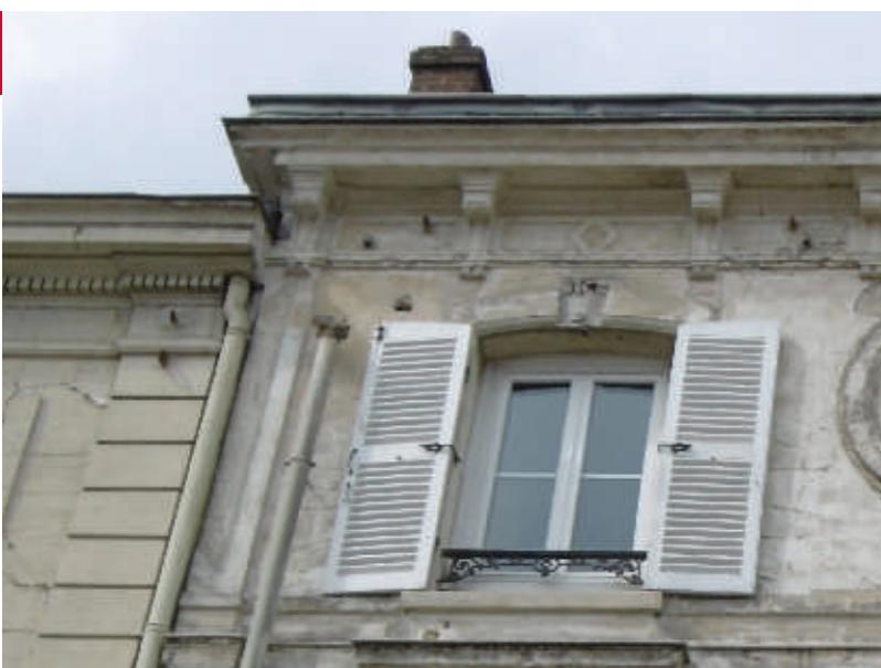
Les détails constructifs s'observent notamment en façade à travers les chaînes, corniches, linteaux et jambages, encadrements de baie, appuis de fenêtre, bandeau...
