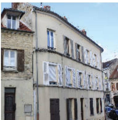
La construction forme un parallépipède rectangle généralement sur trois niveaux, surmonté d'un toit à deux pans entre 35° et 45°. Il est parfois encadré de souches de cheminée maçonnées.
