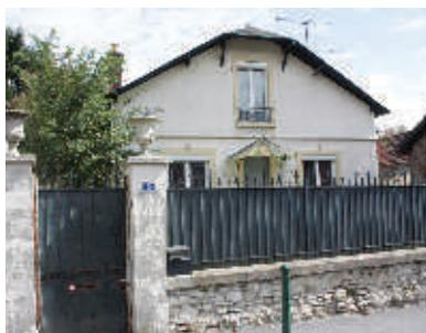
La tuile mécanique, la pierre, la pierre meulière, le moellon calcaire enduit et la brique constituent les matériaux de construction des maisons XIX<sup>e</sup> - début XX<sup>e</sup>. Les modénatures tels que : corniches, bandeaux sont en plâtre, parfois en brique. Les encadrements sont en brique, pierre ou moellon enduit.
