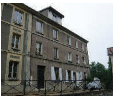
La tuile plate en terre cuite, la pierre et le moellon calcaire enduit constituent les matériaux de construction des petits immeubles de Luzarches. Les nombreuses modénatures tels que corniches, bandeaux, pilastres, modillons, sont en plâtre ou en pierre. Les encadrements de fenêtres sont parfois en pierre ou en moellon enduit. Un soubassement en pierre dure enduit protège le bas du mur.
