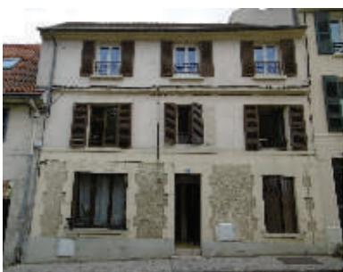
La tuile plate en terre cuite, la pierre et le moellon calcaire enduit constituent les matériaux de construction des petits immeubles de Luzarches. Les nombreuses modénatures tels que corniches, bandeaux, pilastres, modillons, sont en plâtre ou en pierre. Les encadrements de fenêtres sont parfois en pierre ou en moellon enduit. Un soubassement en pierre dure enduit protège le bas du mur.
