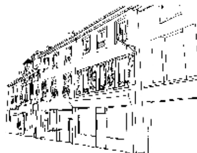
Des commerces sont parfois implantés au rez-de-chaussée
