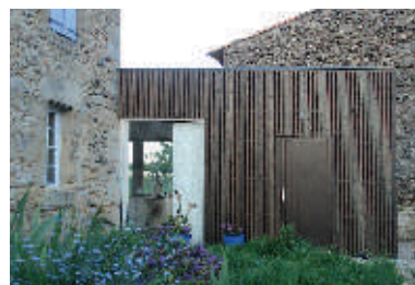
Maison dans le Tarn archi. bonbon architecture
