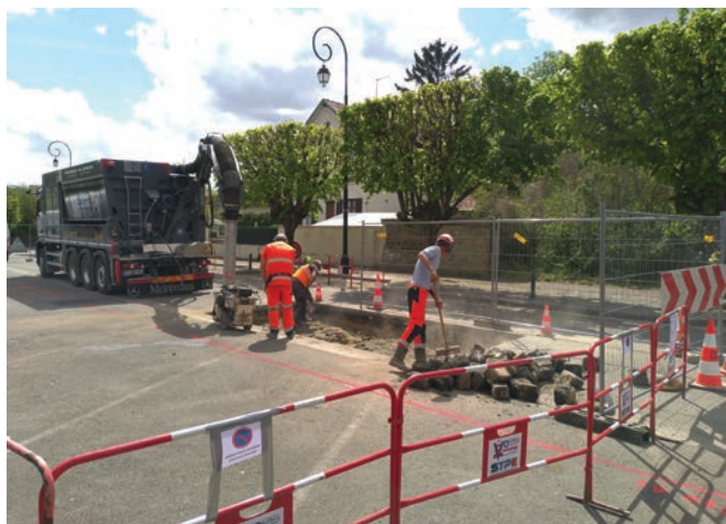
Travaux pour stabiliser la pression d'eau, Avenue du Maréchal Joffre
