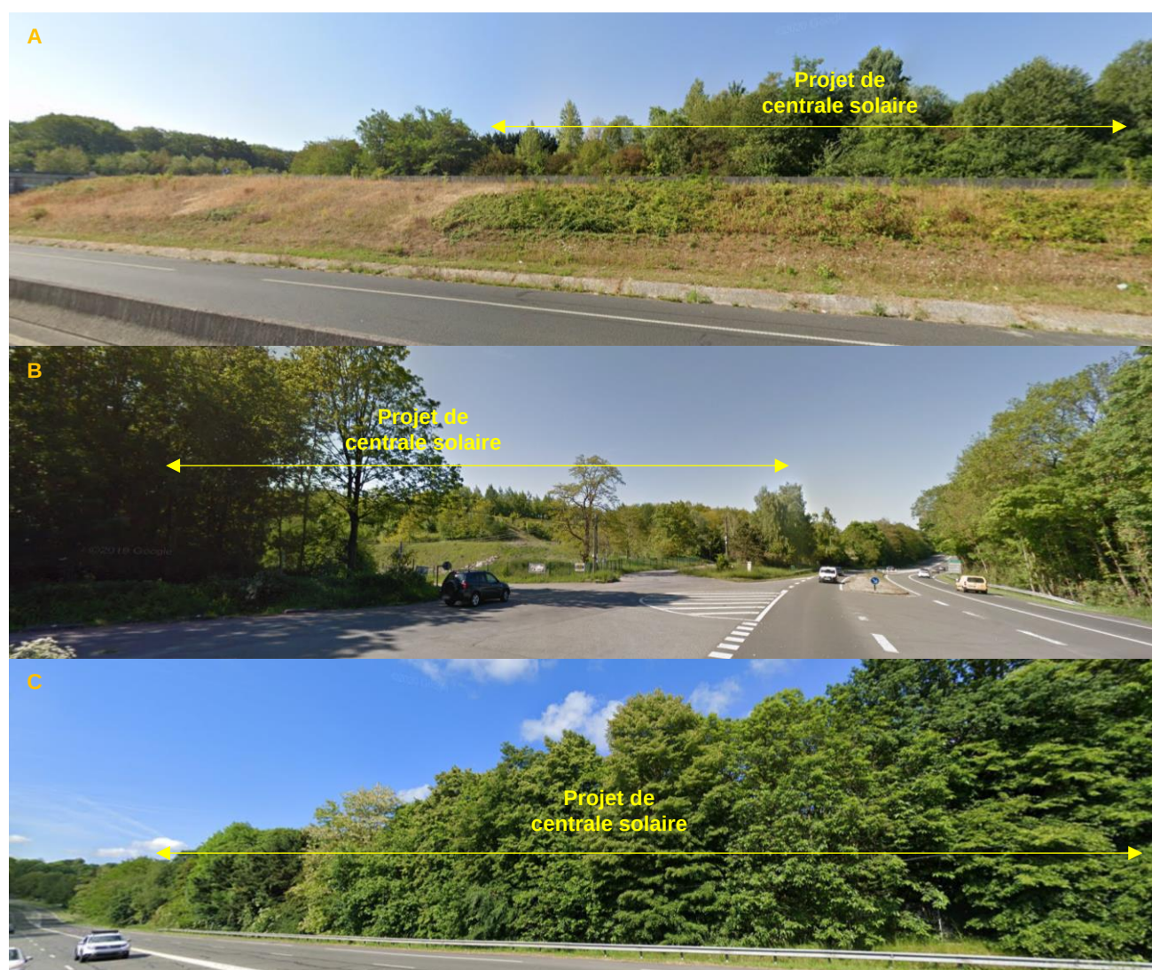
Figure 25 : Photographies aux abords du projet de parc solaire
