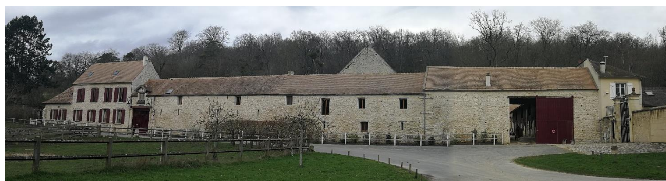
Figure 12 : Ferme d'Hérivaux (et grange, dont on ne voit que le haut du pignon)
