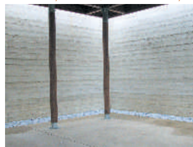
Préau aux Clayes-sous-Bois, archi. Anne Delaunay
