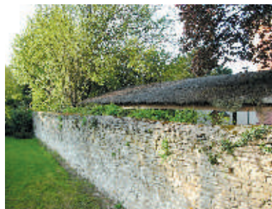
Mur en pierre reprenant l'architecture locale
