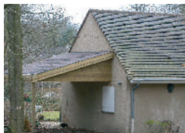
Auvent contemporain bien intégré, accolé à la maison
