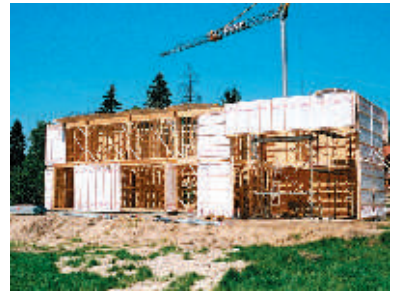
Chantier d'une maison à ossature bois
