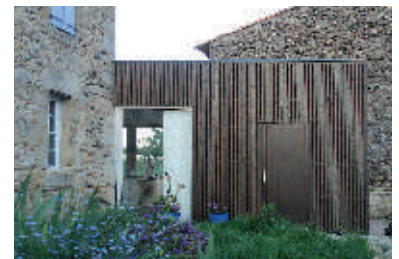
Maison dans le Tarn archi. bonbon architecture
