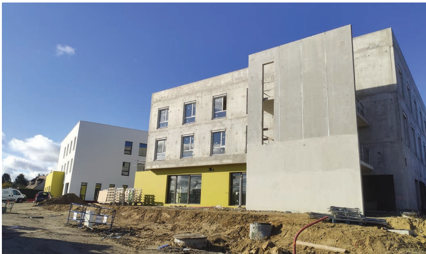
Chantier en cours, rue du Freval
