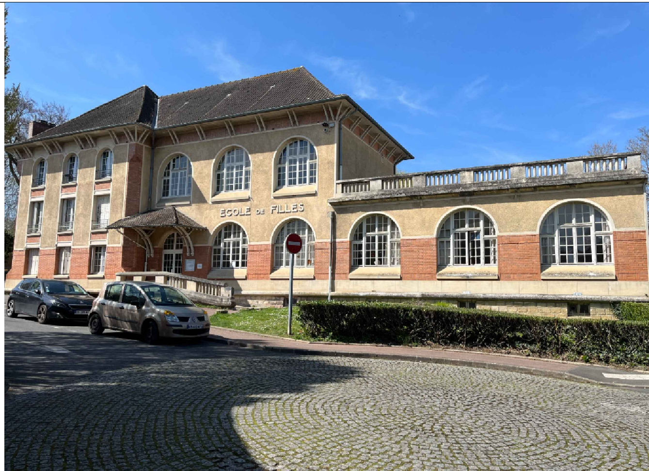
Vue 1 Est Entrée du centre de loisirs
