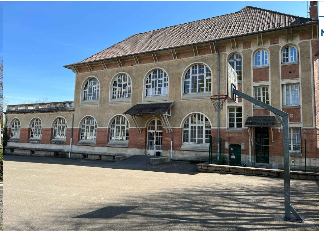
Vue 2 Nord-Ouest Façade côté cour du centre de loisirs
