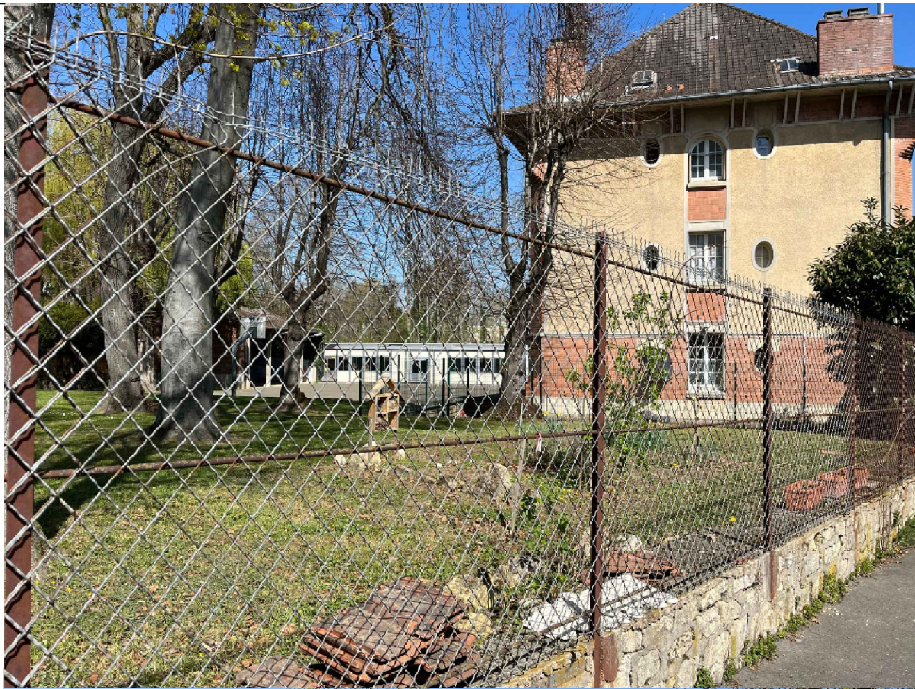
Vue 5 Sud Logements depuis le trottoir rue Selliers
