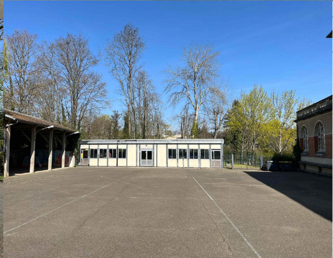
Vue 8 Sud Cour intérieur
