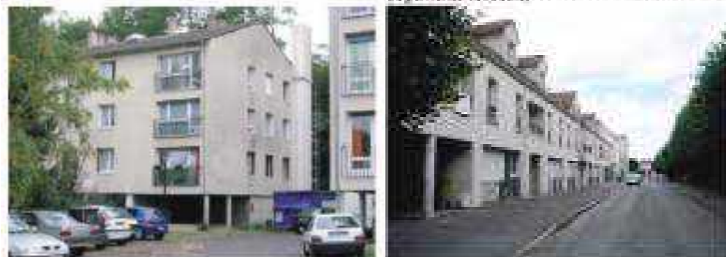
Premiers logements collectifs résidentiels Île-de-France Rue de la Liberté : une typologie de maisons de ville mais une entrée groupée plusieurs logements collectifs
