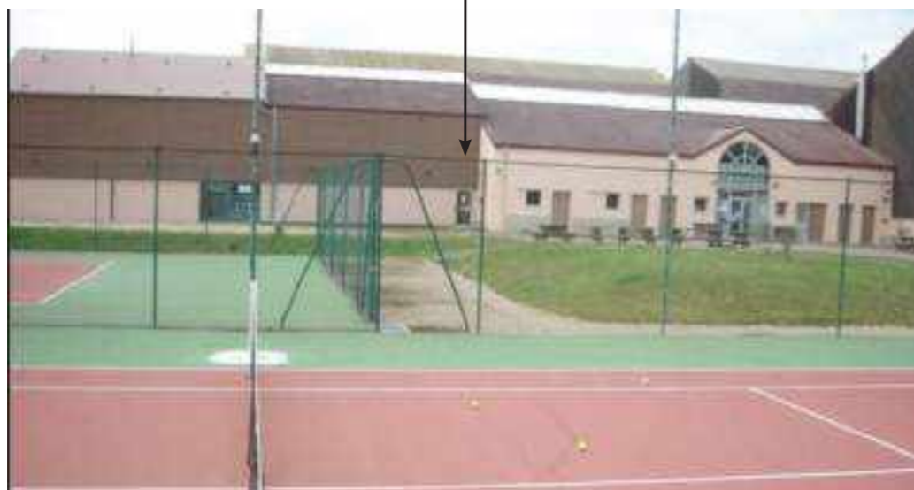
Les bâtiments à vocation d'équipements sportifs, sans intérêt architectural, pourront évoluer
