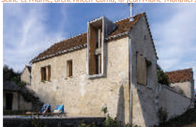
Grange en Indre et Loire archi. Belus Henocq
