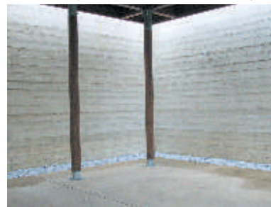
Préau aux Clayes-sous-Bois, archi. Anne Delaunay
