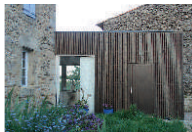
Maison dans le Tarn archi. bonbon architecture
