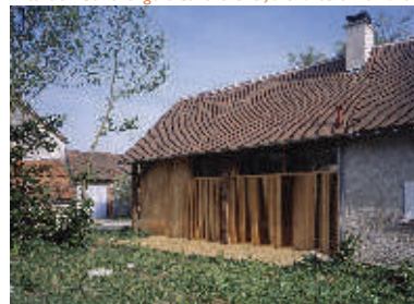
Habitations de composition simple, avec des volets en bois sous forme de claustra qui s'ouvrent ou se ferment, formant un auvent à la terrasse
