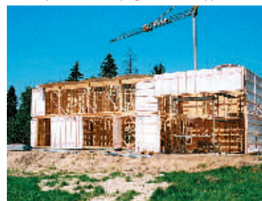
Chantier d'une maison à ossature bois
