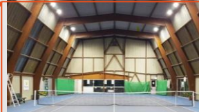
Courts de tennis 1 couvert 3 extérieurs
