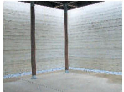
Préau aux Clayes-sous-Bois, archi. Anne Delaunay
