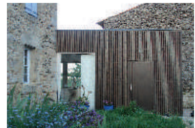
Maison dans le Tarn archi. bonbon architecture
