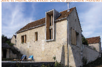
Grange en Indre et Loire archi. Belus Henocq
