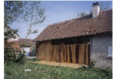
Habitations de composition simple, avec des volets en bois sous forme de claustra qui s'ouvrent ou se ferment, formant un auvent à la terrasse
