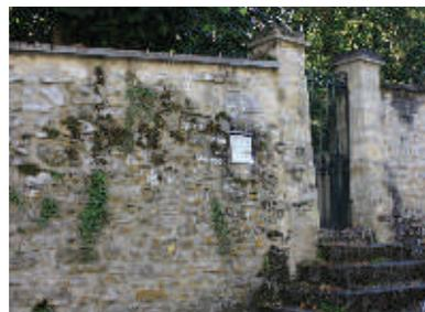
Les murs de clôture des maisons du centre-bourg sont construits en moellons de calcaire et/ ou de grès apparents ou recouverts d'un enduit à la chaux. Ils sont rarement en brique ou pierre de taille. Les murs de clôture sont protégés des intempéries par un couronnement maçonné en pierre, en enduit, en brique ou par un chaperon en tuile.
