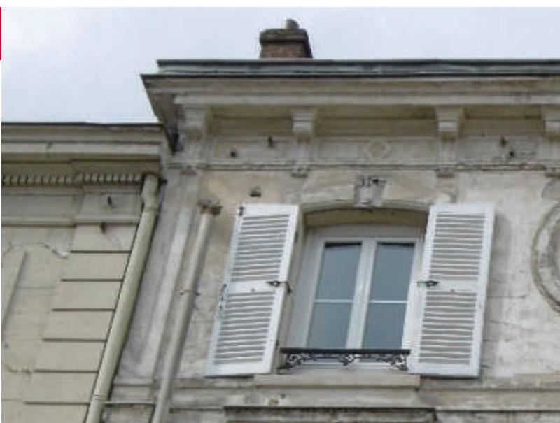
Les détails constructifs s'observent notamment en façade à travers les chaînages, corniches, linteaux et jambages, encadrements de baie, appuis de fenêtre, bandeau...
