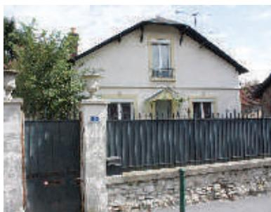
La tuile mécanique, la pierre, la pierre meulière, le moellon calcaire enduit et la brique constituent les matériaux de construction des maisons XIXème - début XXème. Les modénatures tels que : corniches, bandeaux sont en plâtre, parfois en brique. Les encadrements sont en brique, pierre ou moellon enduit.
