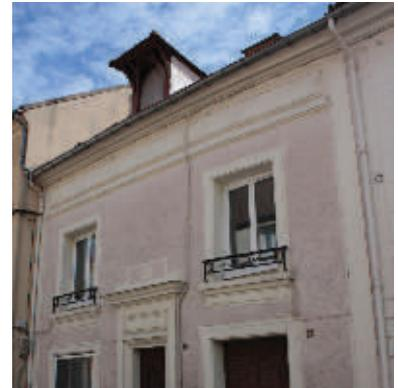
Quand les maçonneries sont en pierre de taille, les appareillages et les compositions de façade sont soignées. Non enduites, elles laissent visible la finesse des joints et l'appareillage.
