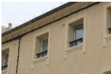
Les fenêtres sont plus hautes que larges. Les linteaux sont droits, rarement cintrés, en moellon ou en bois. Ils sont recouverts d'un enduit. En brique ou en pierre de taille, ils restent apparents. Les jambages sont souvent en maçonnerie enduite.
